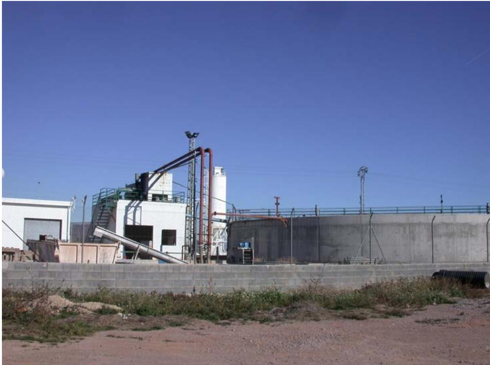
*Figura 6.3. Depuradora de Mare Nostrum. Recibe aguas residuales industriales procedentes de la industria del curtido, en Vall de Uxó. Vierte el efluente al cauce del río Belcaire, a escasos metros de la EDAR*
