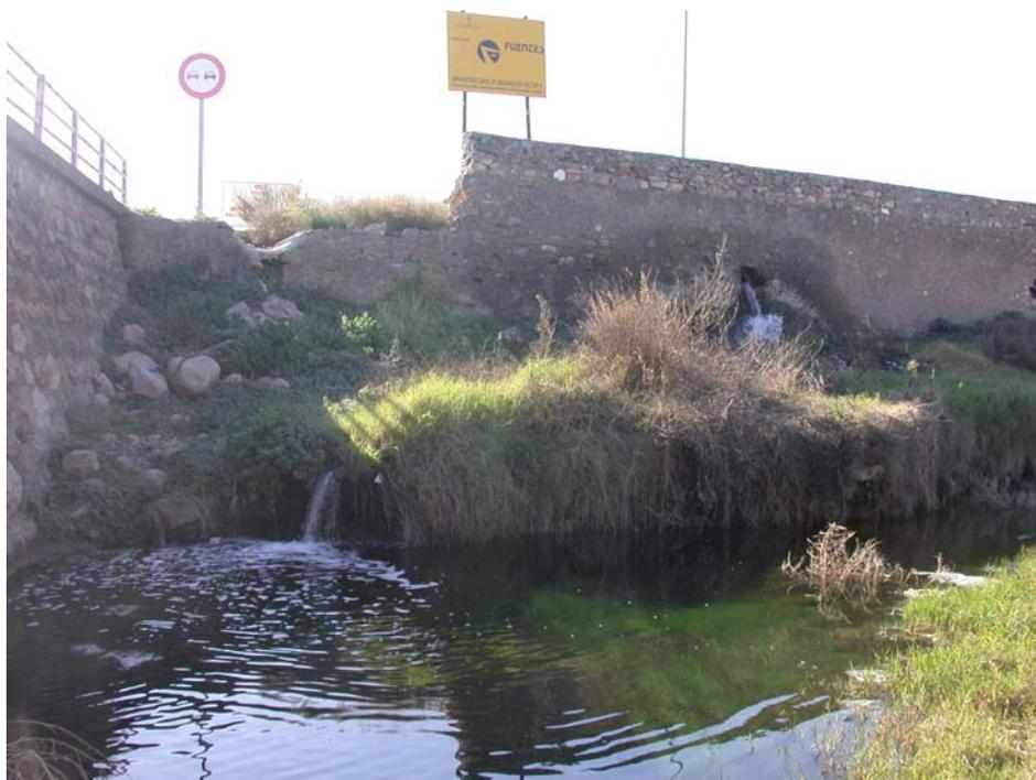
*Figura 6.5. Vertido al cauce del río Belcaire, de la salmuera de rechazo de la planta de ósmosis inversa de Vall d'Uixó, a la altura del cruce con la carretera N-225.*
