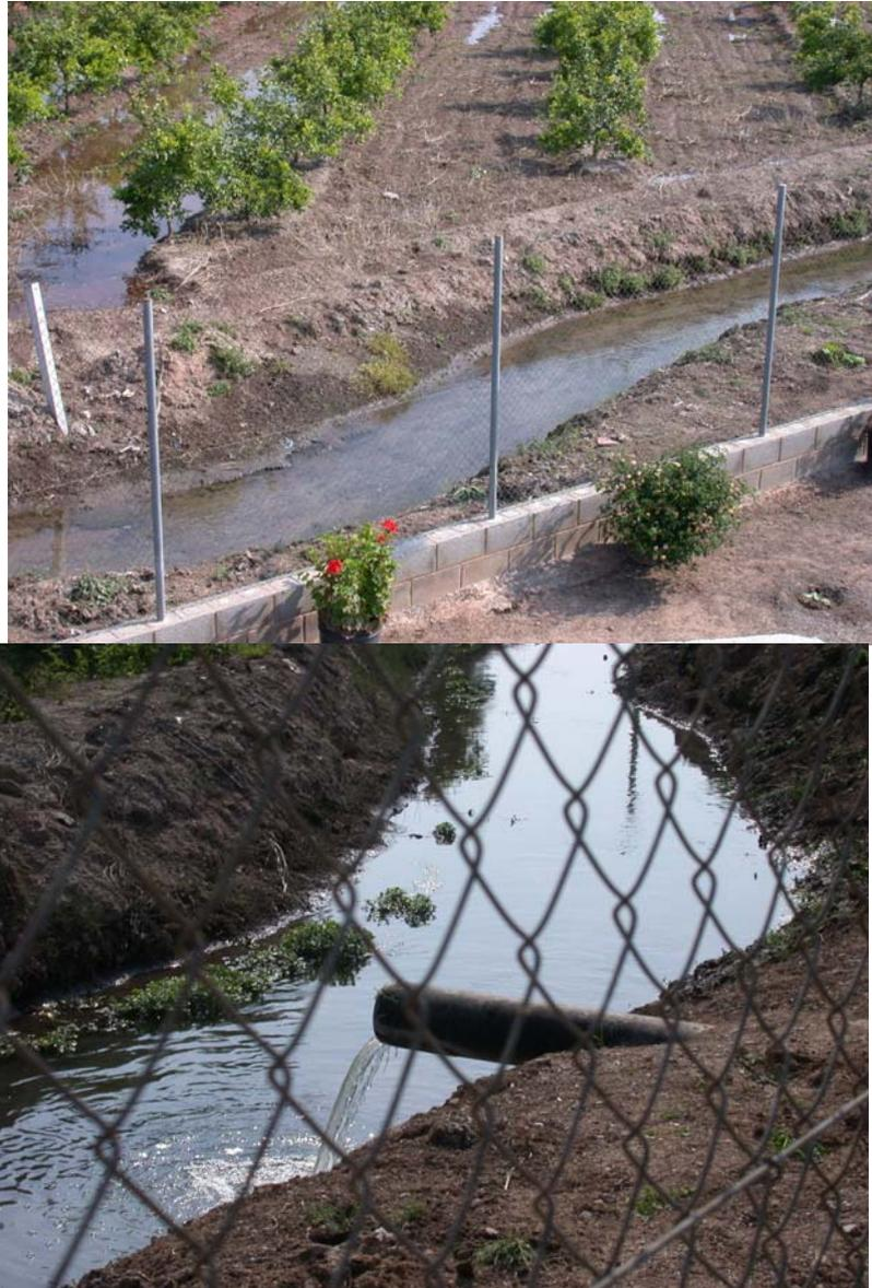
*Figura 6.2. Salida del efluente de la depuradora de La Llosa a una acequia de riego.*
