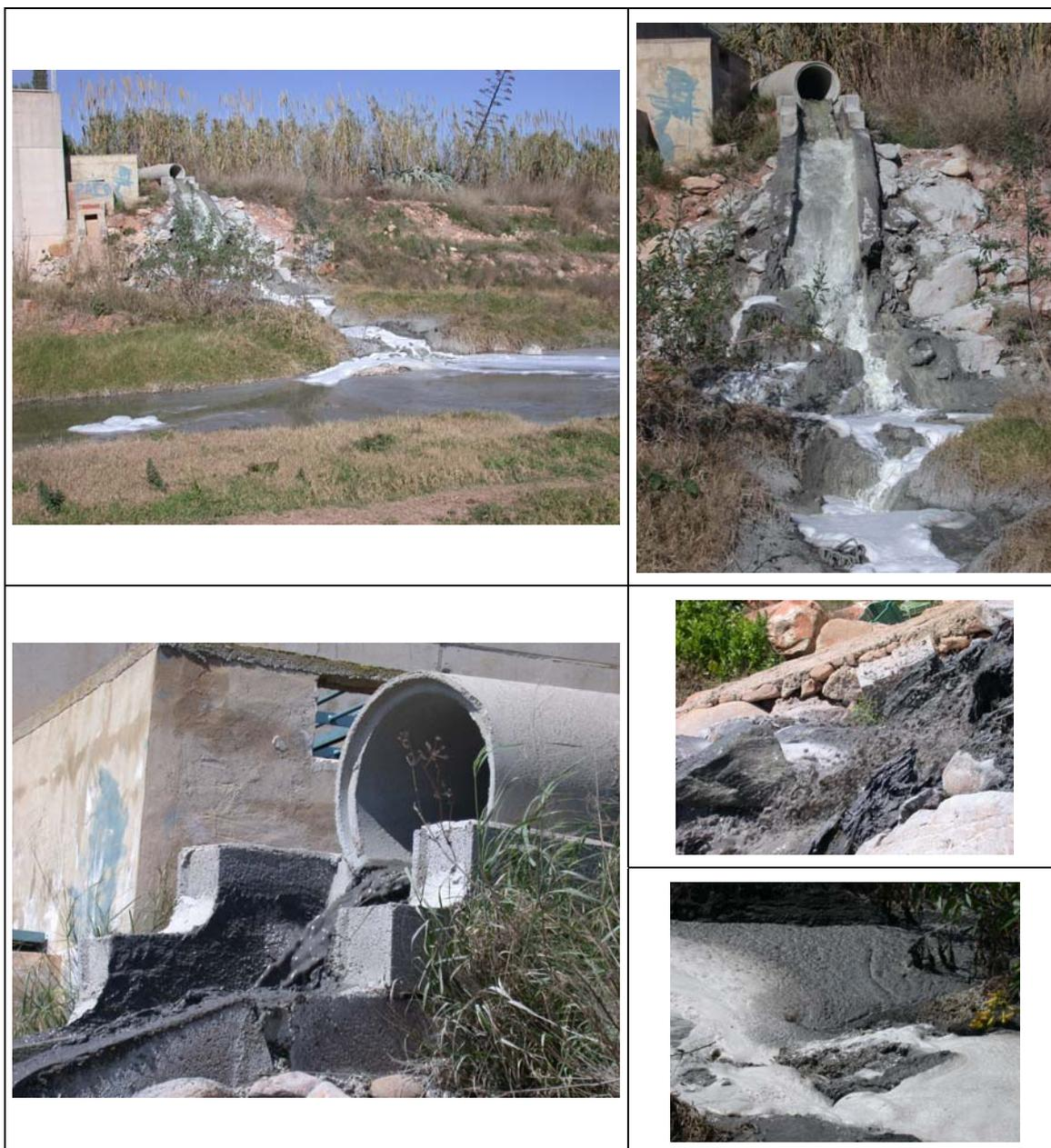
*Figura 6.4. Salida del efluente de la depuradora de aguas residuales procedentes de la industria del curtido Mare Nostrum al cauce del río Belcaire (05/02/04). Obsérvese la coloración del efluente.*
